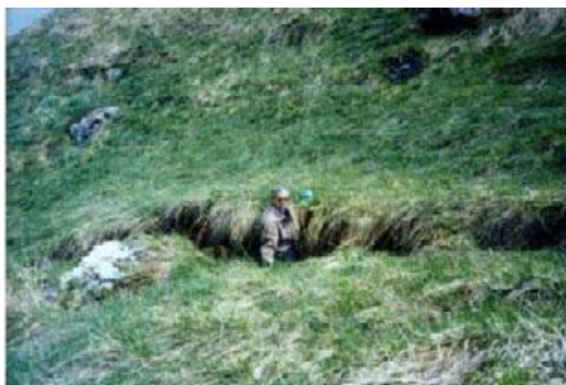
Fot. 4-3 Jedna ze skarp osuwowych, istniejących przed rozpoczęciem prac
