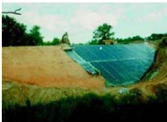
Fot.5-1 Pokrywanie zapory membraną z geowłókniny
