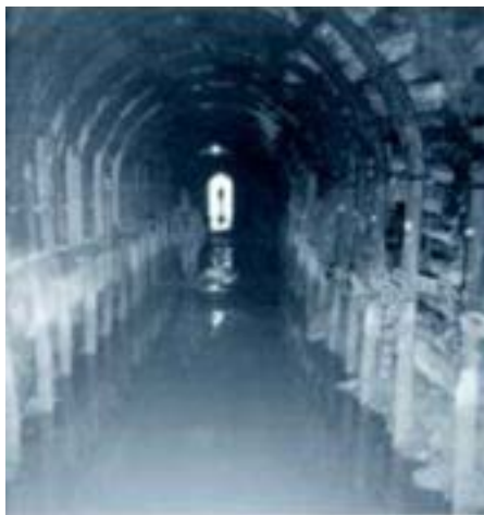
Fot. 4-5 Widok sztolni w trakcie budowy
