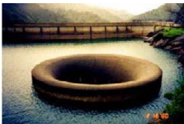
Fot. 5-10 Przelew szybowy
