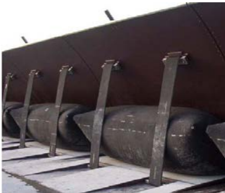
Fot. 5-8 Grodza sterowana nadmuchiwaną powłoką gumową
