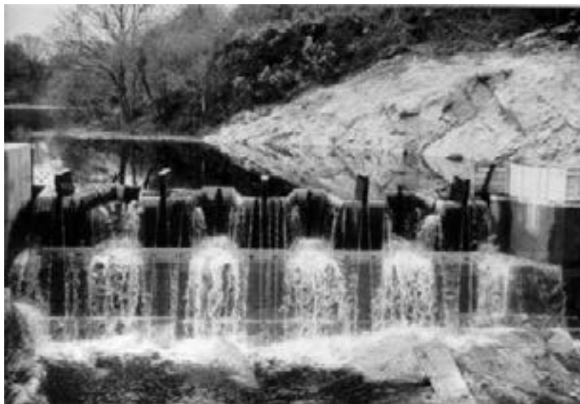
Fot. 5-9 Zamknięcia typu bezpiecznikowego „fusegate” (Hydroplus)
