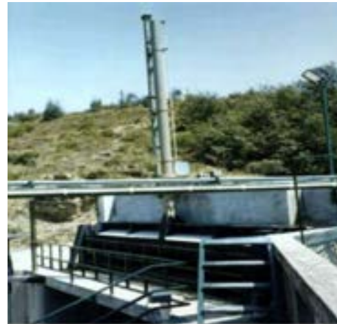
Fot. 5-18 Napęd zasowy za pomocą siłownika hydraulicznego
