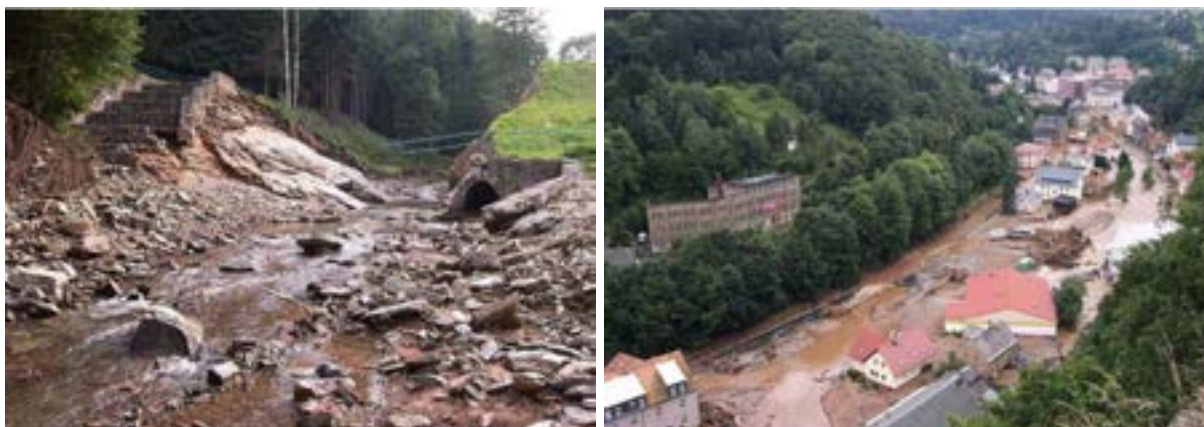
Fot. 5-4 Przerwanie małej zapory: wyrwa i powódź w dole rzeki
