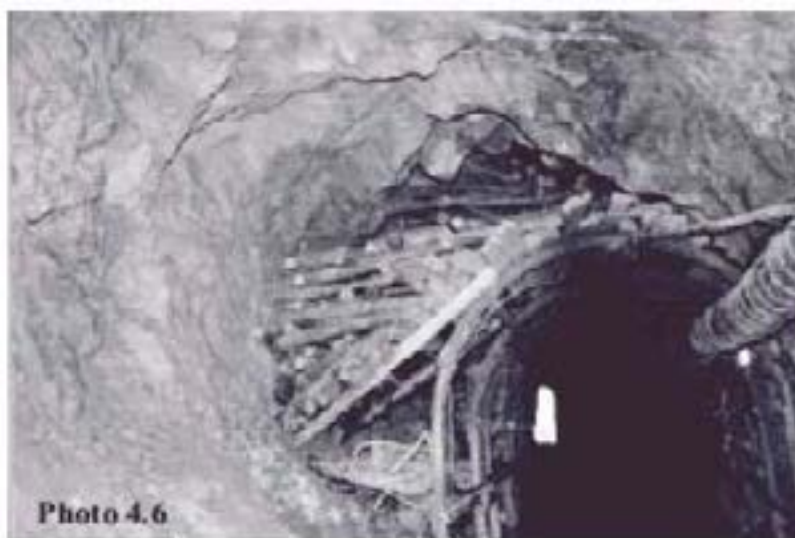
Fot. 4-6 Betonowanie sztolni
