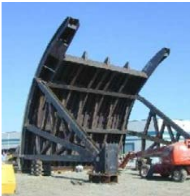
Fot. 5-21 Zamknięcie segmentowe (po lewej) i jego instalowanie na przyczółkach betonowych (po prawej)
