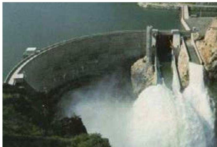
Fot 5-3 Przykład zapory łukowej
