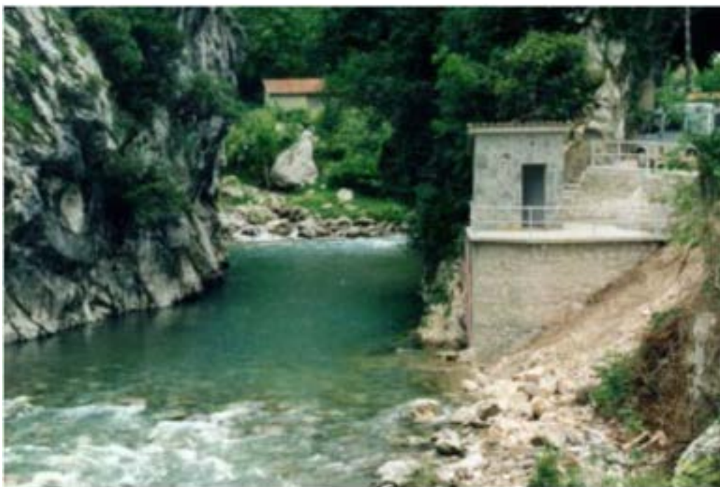
Fot.3-1 Stacja wodowskazowa na rzece
