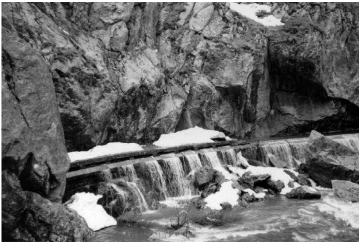
Fot.5-23 Przelew boczny
