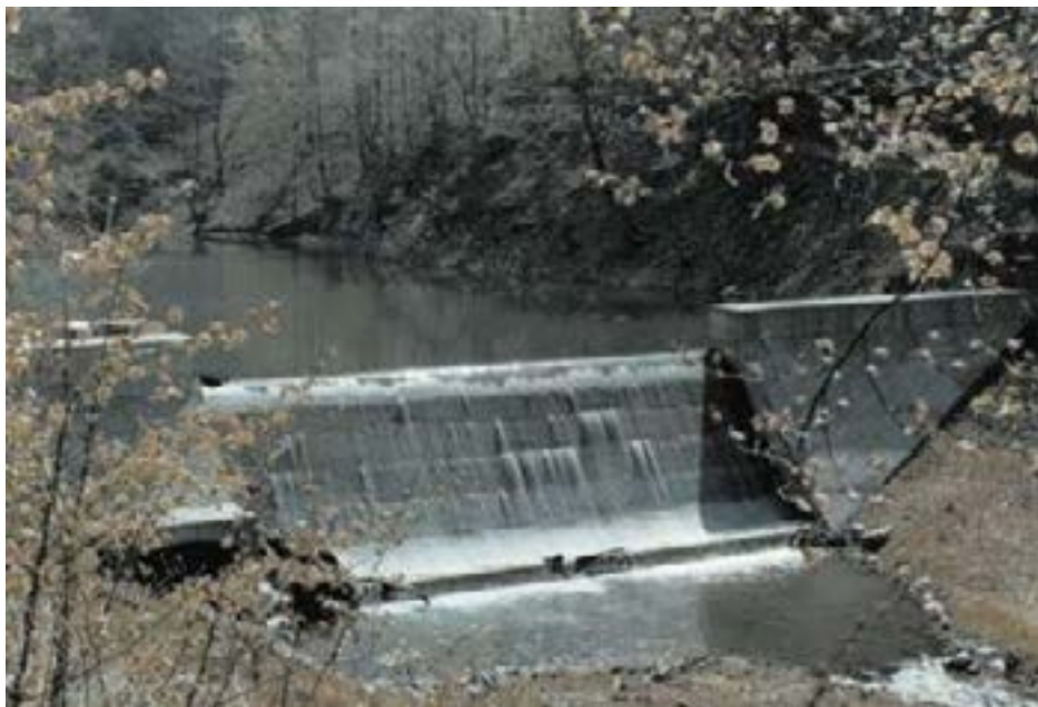
Fot. 5-5 Próg przelewu o kształcie praktycznym
