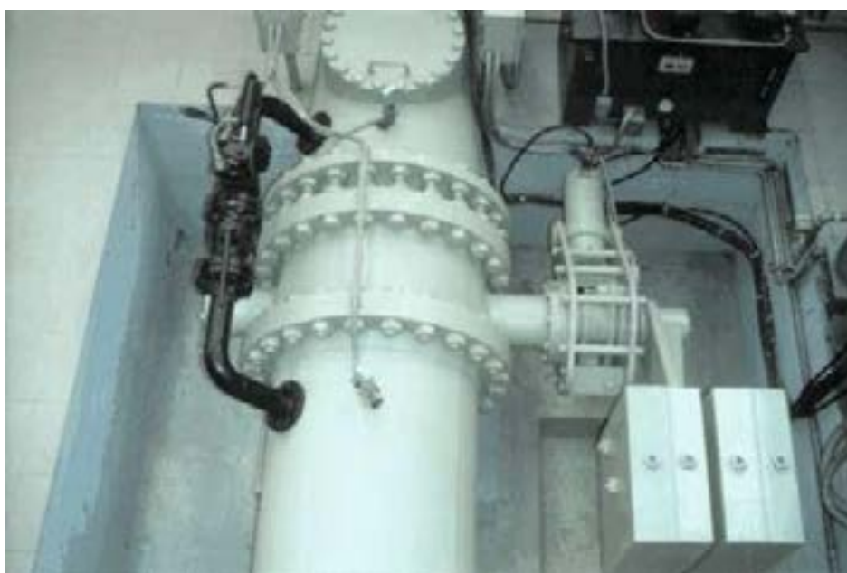
Fot. 5-20 Zawór motylowy z napędem hydraulicznym
