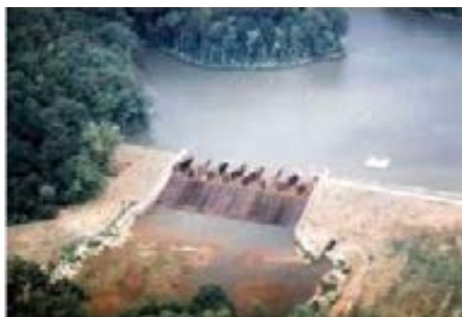
Fot. 5-12 Jaz z przelewem labiryntowym
