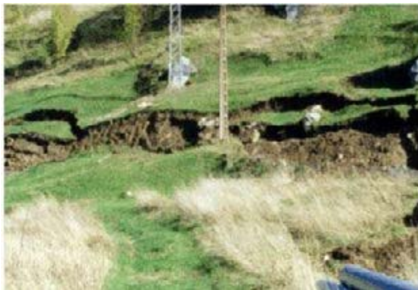
Fot. 4-1 Widok ogólny prawej skarpy rzeki
