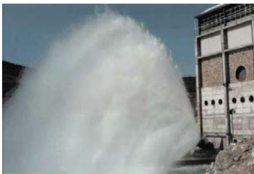
Fot. 5-26 Wytrysk wody z zaworu upustowego
