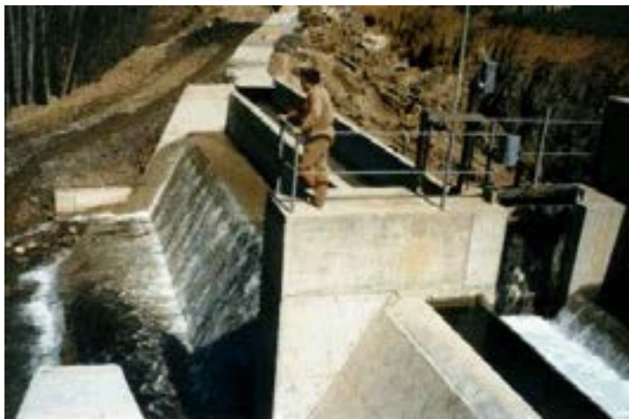
Fot. 5-17 Zasuwa regulacyjna z mechanizmem zębatkowym
