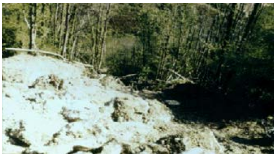
Fot. 4-10 Zaporę uszkodzoną przez sufozję
