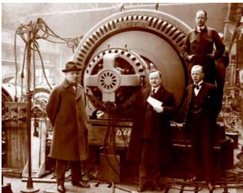
Odbiór przez dyr. Hoffmanna z fabryki ASEA w Szwecji prądnicy dla elektrowni Gródek
